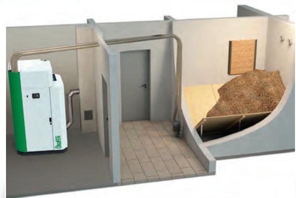
Succión neumática con silo de obra
